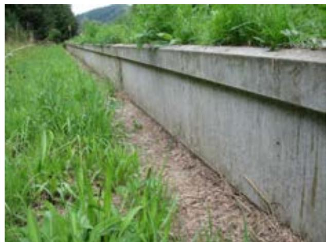
PHOTOS 1A ET 1B : EXEMPLE DE BORDURE EN BETON, LE REBORD SUPERIEUR EMPECHE LES AMPHIBIENS D'ESCALADER LE MURET. LA BORDURE EN BETON INFERIEURE LIMITE LE DEVELOPPEMENT DE LA VEGETATION ET FACILITE LE DEPLACEMENT DE LA PETITE FAUNE.
