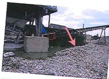
Mise en place d'un merlon en gravier pour éviter le passage des engins dans une zone de reproduction du Crapaud vert.
