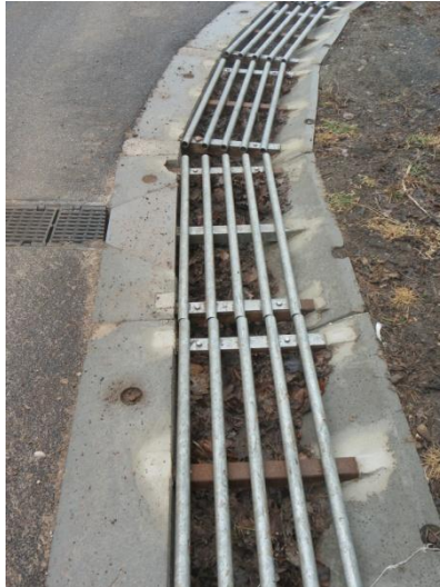
Figure 16 : Passage canadien avec pente douce sur le côté droit
