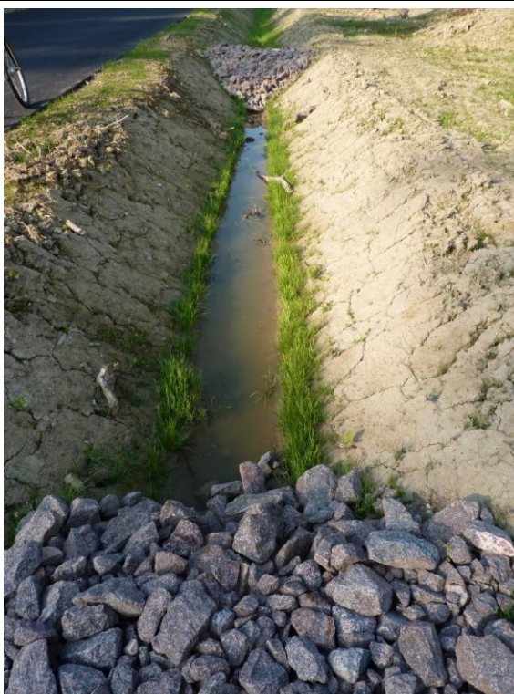
Figure 8 : Aménagement de fossés d'évacuation
