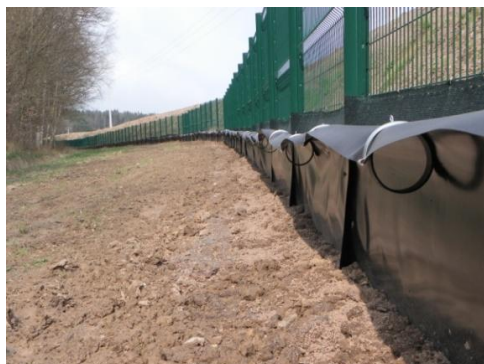
Figure 3 : Clôture imperméable avec système anti-retour
